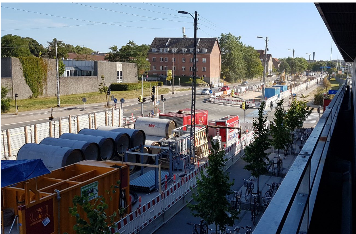
Ledningsarbejde ved Buddinge Station set mod den tidligere Buddinge Rundkørsel.
