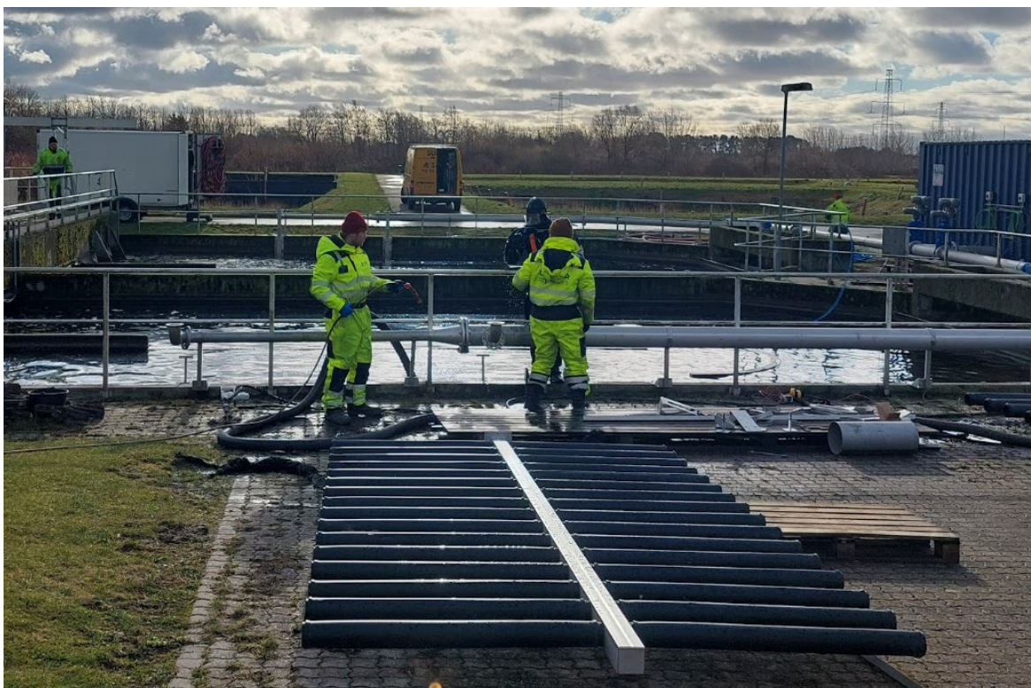
Bundbeluftergitter klar til montage på Slangerup Renseanlæg.
