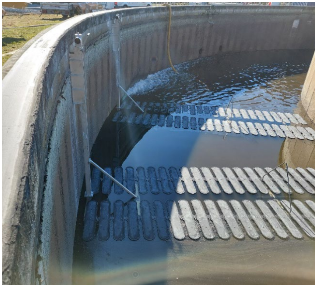
Ny bundbeluftning og omrører på Stenløse Renseanlæg.
