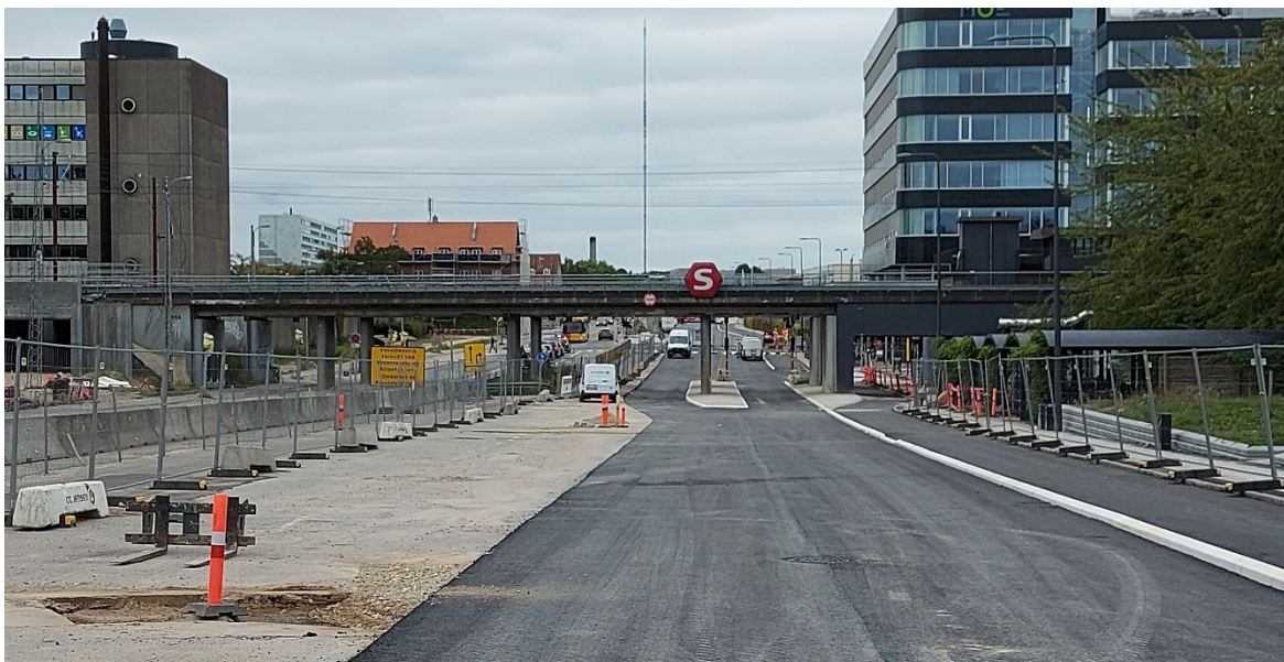
Buddingevej ved Buddinge Station efter ledningsarbejde er afsluttet og Hovedstadens Letbanes entreprenør har anlagt det nye vejtracé.
